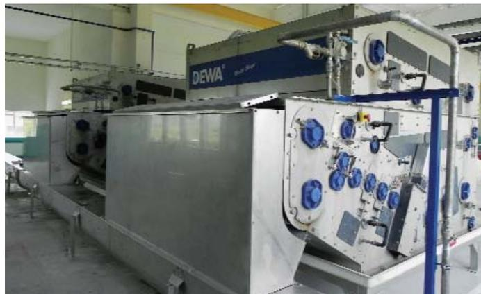
Шнековый конвейер и пресс-фильтры цеха механического обезвоживания осадка (до и после реконструкции)
